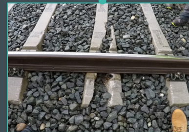
Defekte des Unterbaus
