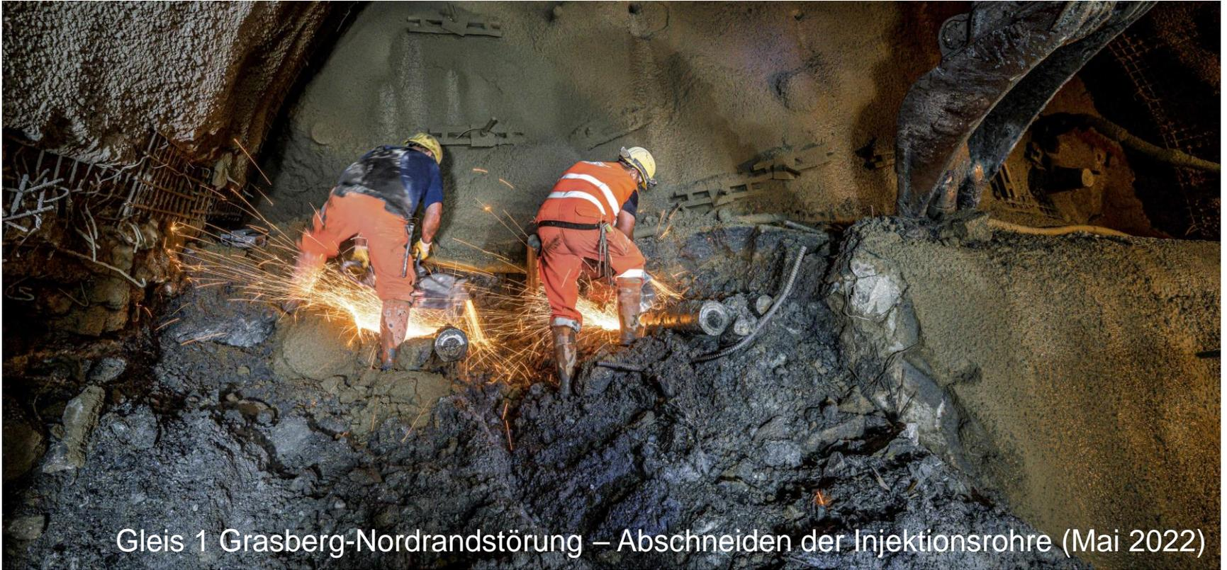
Gleis 1 Grasberg-Nordrandstörung – Abschneiden der Injektionsrohre (Mai 2022)
