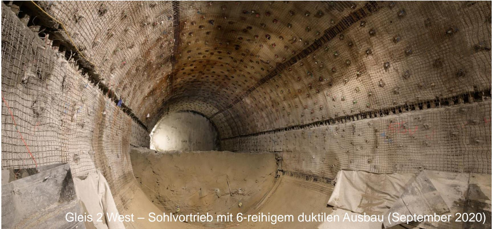
Gleis 2 West – Sohlvortrieb mit 6-reihigem duktilen Ausbau (September 2020)
