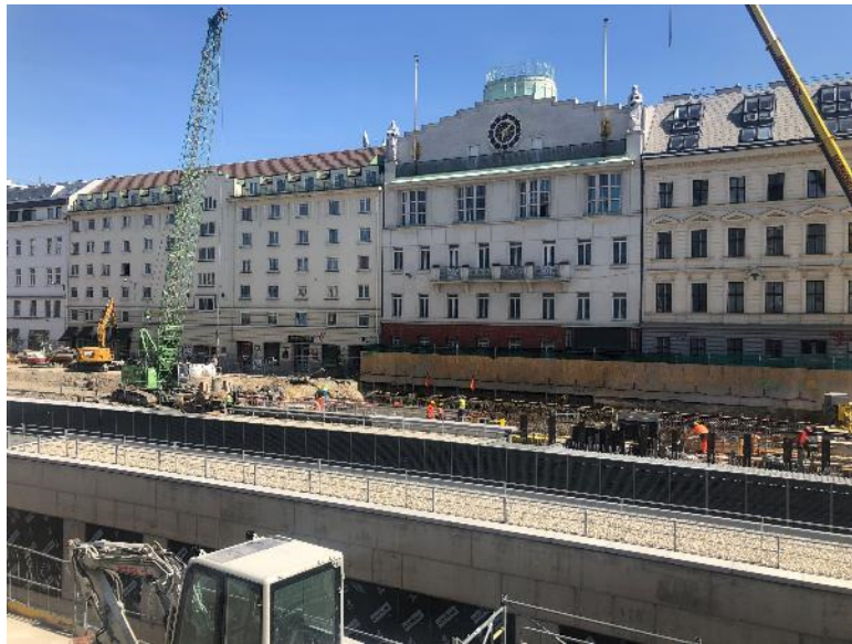
Herstellen BA 4 - Decke über N-1 BT R2
