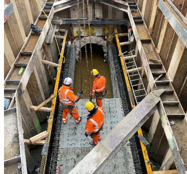
Herstellen Anschlusskammer - Decke
