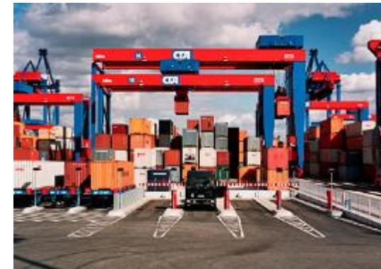
Terminal Stapelbereich - Vollautomatischer Betrieb
