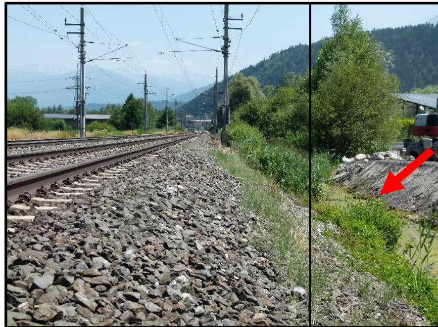
Wasserandrang kombiniert mit Dammgewicht verursacht Setzungen.
