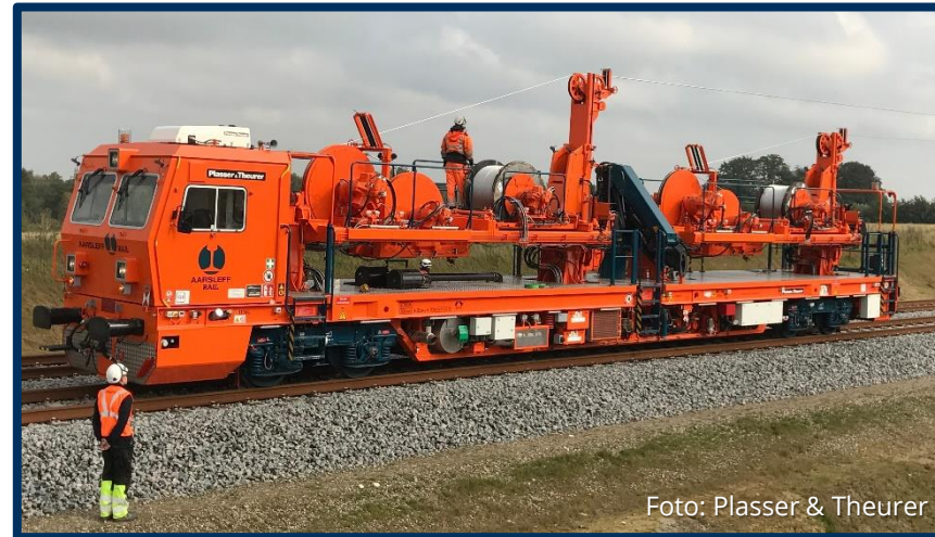
Fahrdraht und Tragseil simultan verlegen
